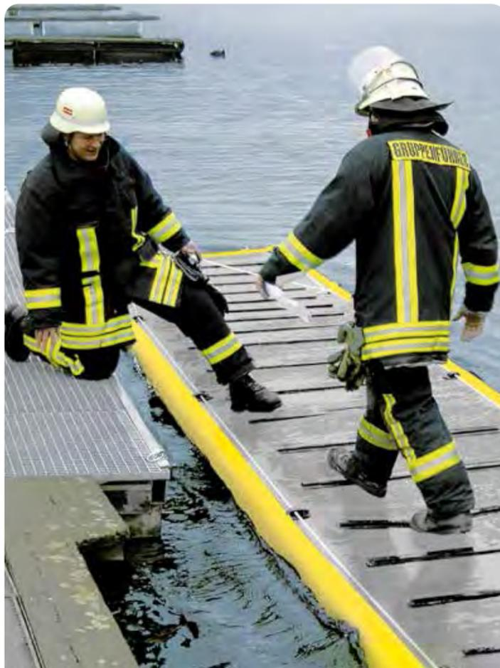
Sicherer Gang durch Anti-Rutsch-Streifen
